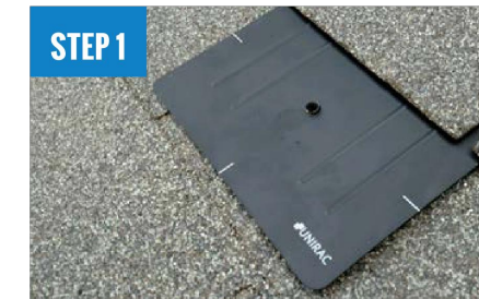
INSTALL FLASHKIT PRO FLASHING
