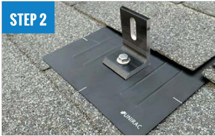
STEP 2 INSTALL L-FOOT
